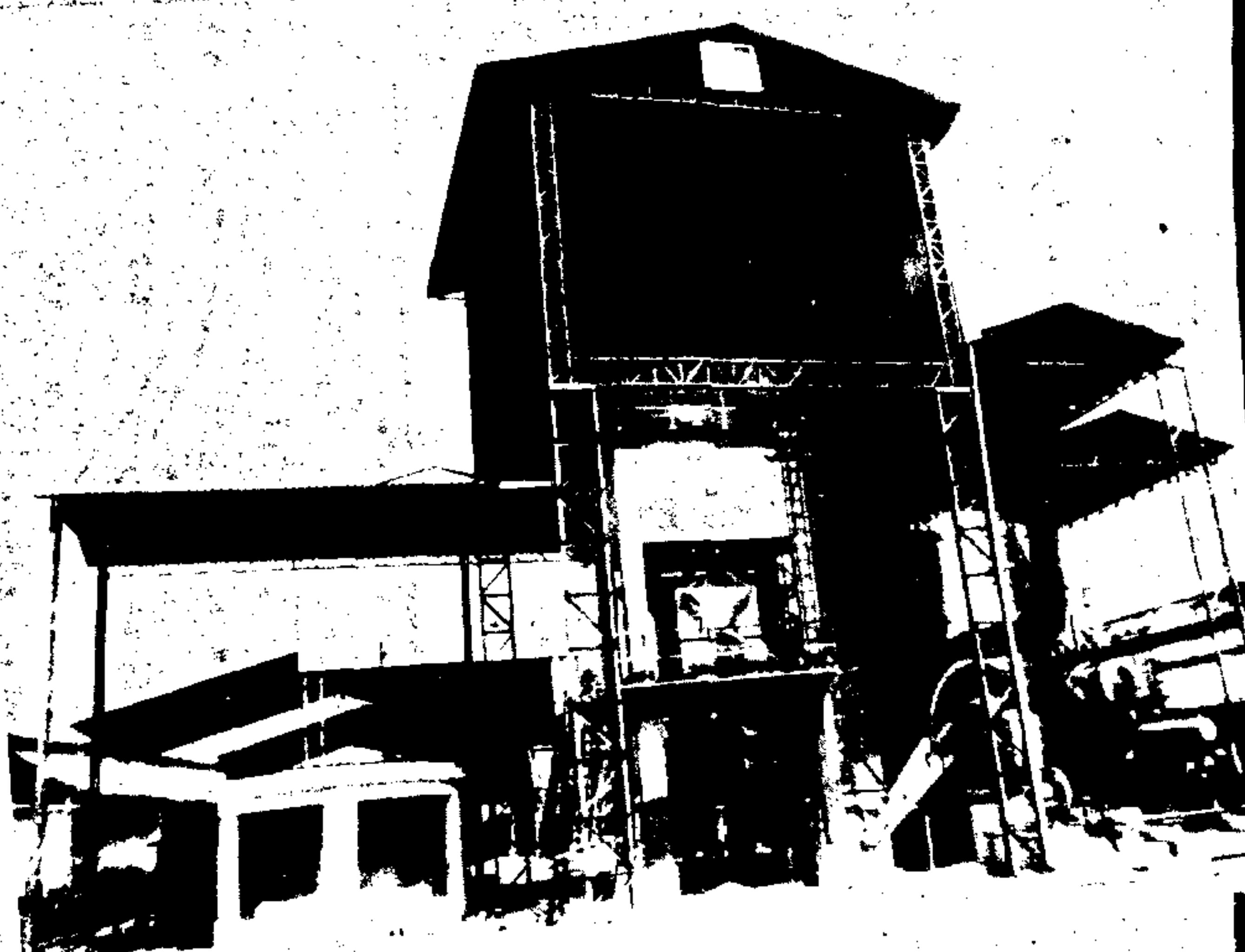
Já está terminada e funcionando à plena força a nova Usina de Asfalto da Barra Funda, com capacidade de produção de 100 toneladas/hora. Construída na atual Administração, esta nova unidade se destina a atender à crescente demanda de material para os programas de asfaltamento, recapeamento e tapa-buracos. Última página
